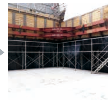
⑥ 養生を外して先やり防水完了
