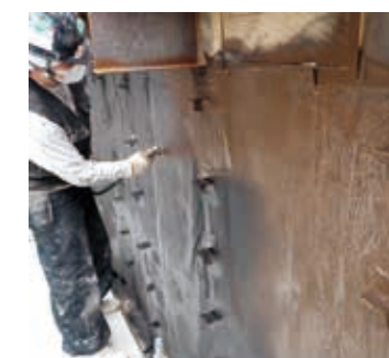
④ ガスファルト吹付け
