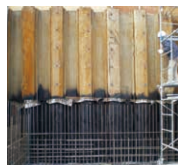
シートパイル
