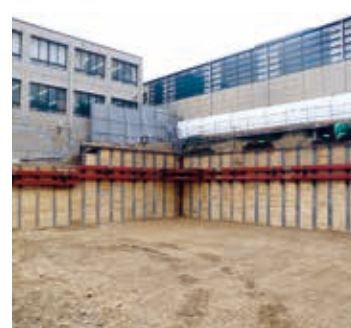
親坑横矢板壁
